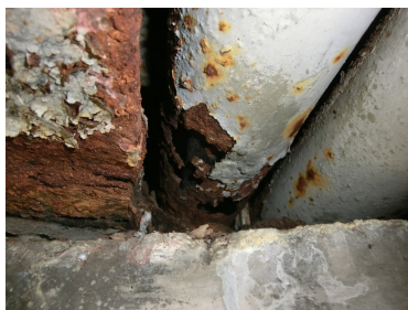
【塗装後10年程度で橋台際が腐食し、折損脱落した橋梁添架管路】
