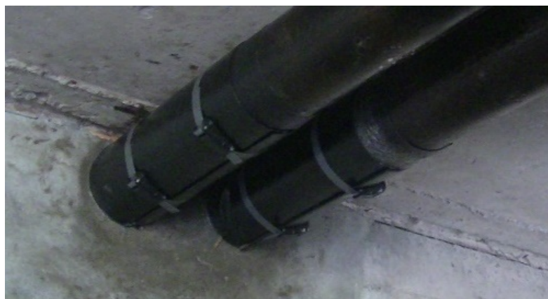
【WI-MARY工法施工状況】
