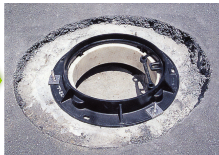
【鉄枠据付け】
