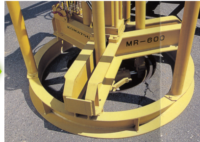
【鉄枠引き抜き】
