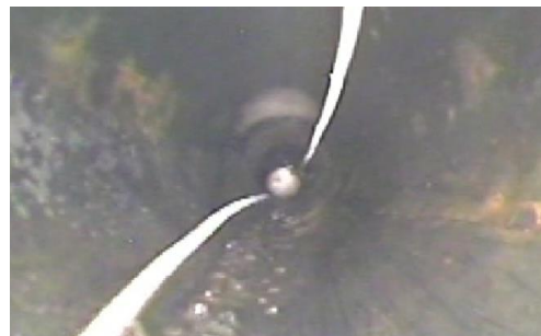
施工後の管路内状況
