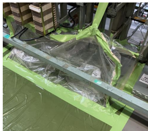
局所隔離の状況
