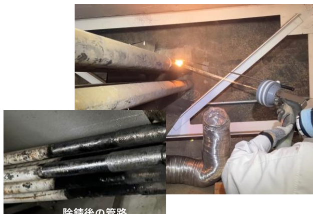
除錆後の管路
