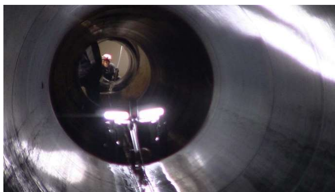
【円形暗渠の点検状況】
