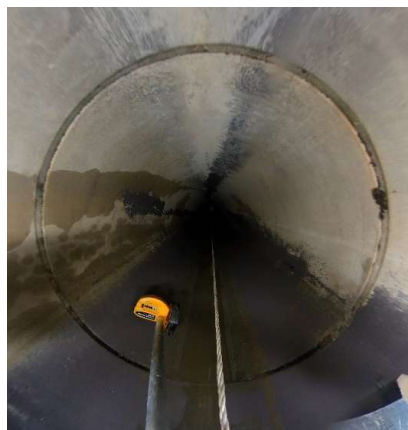
【円形暗渠の点検画像】
