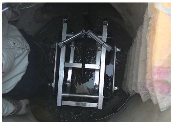
【MHへの設置状況】
