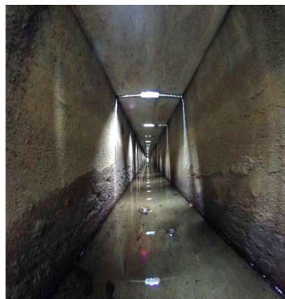
【矩形暗渠の点検画像】
