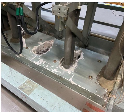
MDF～局内MHIに使用されているアスベスト板
