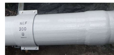
補修後のFRP管
