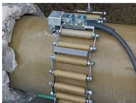
電線共同溝のFRP管切断状況
