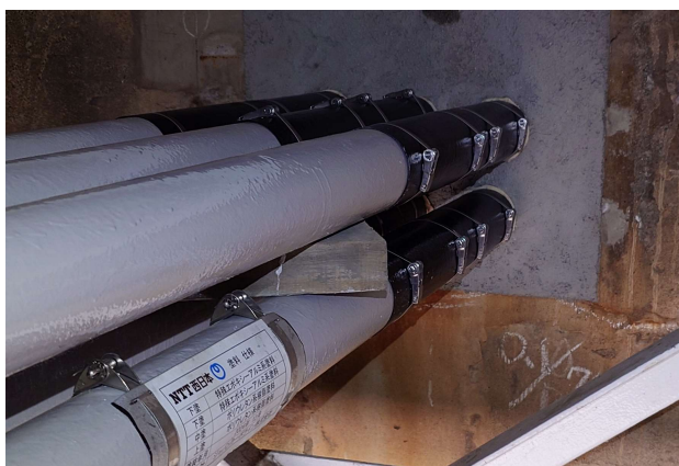
管路塗装工事に合わせて、 WI-MARYを施工した例
