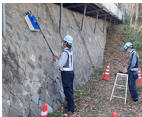
擁壁背面探査
