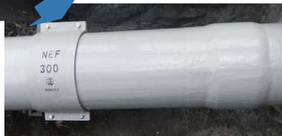
補修後のFRP管
