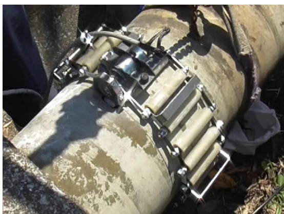
電線共同溝のFRP管切断状況
