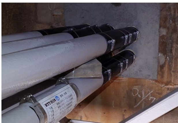
管路塗装工事に合わせて、 WI-MARYを施工した例
